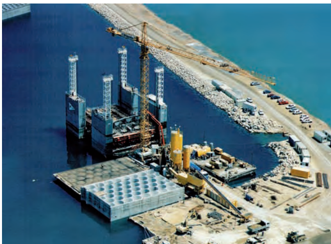
Figura 6.12.1 C Fabricación de cajones
