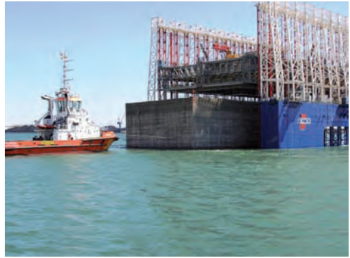
Figura 6.12.7 B Botadura del cajón
