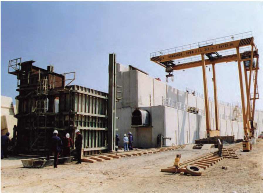
Figura 9.2.2 A Construcción espaldón con galería
