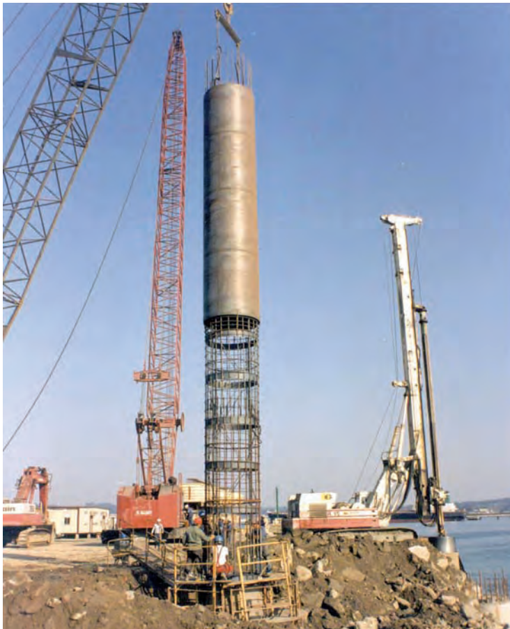
Figura 8.2.2.b B Colocación de armaduras
