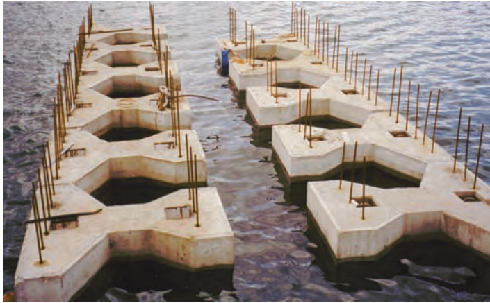
Figura 8.1.3.d A Encofrado perdido
