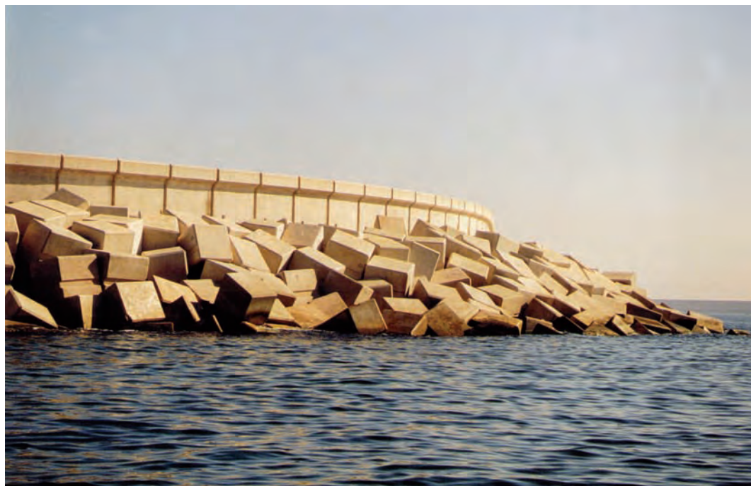
Figura 7.1.10.a Espaldón de dique en talud
