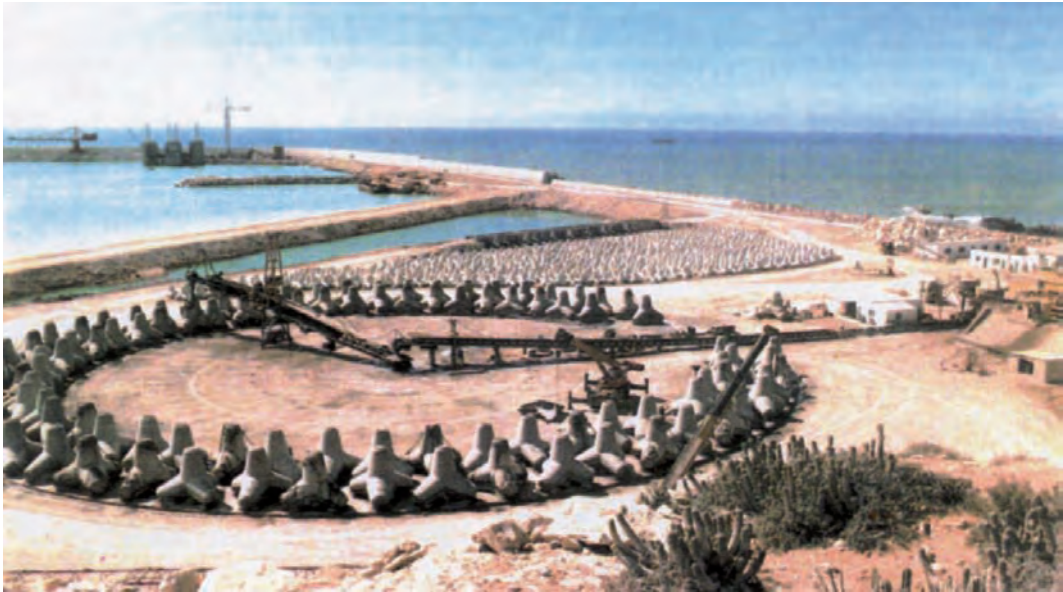
Figura 6.11.2 E Parque circular de fabricación de Tetrápodos
