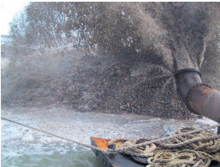
Figura 6.2.2.b B Relleno hidráulico
