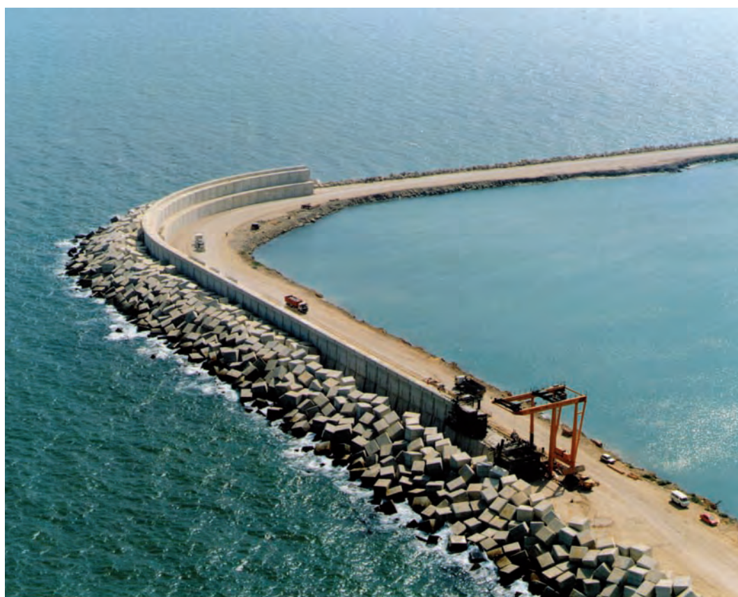
Figura 7.1.10.b Ejecución del espaldón del dique
