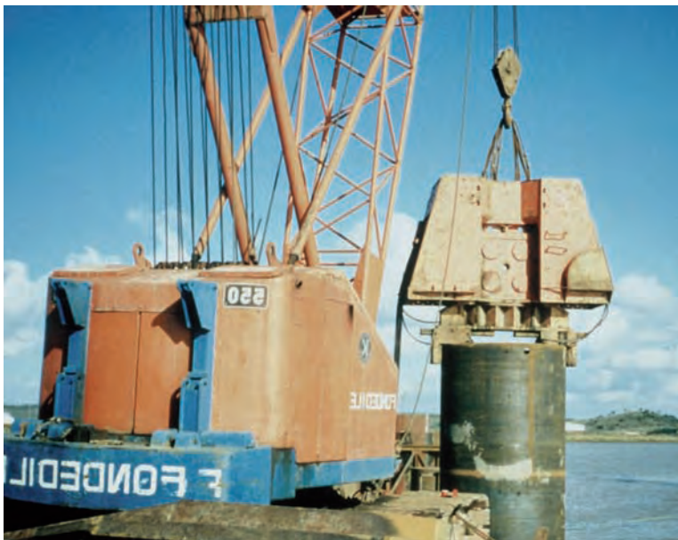
Figura 8.2.5.e B Hinca de pilote metálico con martillo vibrador
