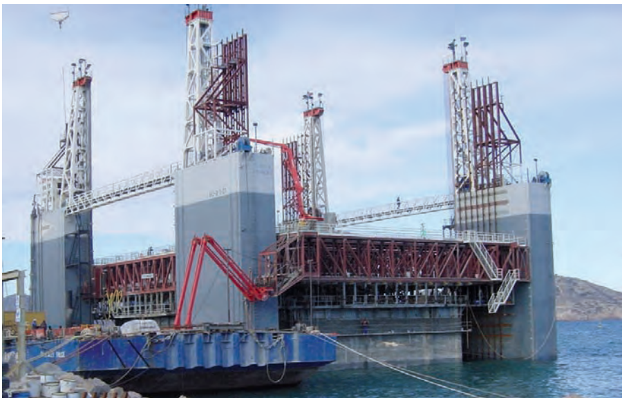
Figura 6.12.2 A Dique flotante
