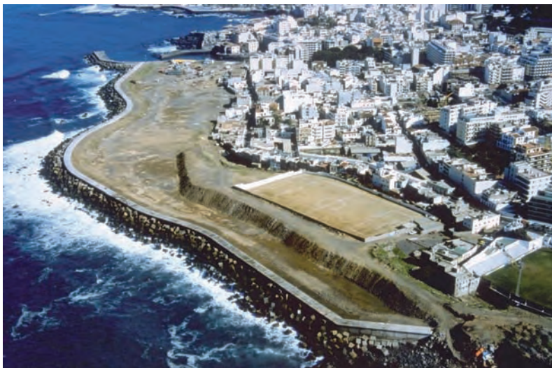
Figura 6.10.2 B Manto de protección ante el oleaje
