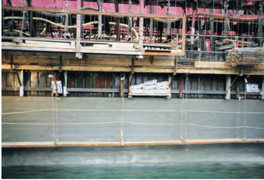
Figura 6.12.6 A Paramento del cajón
