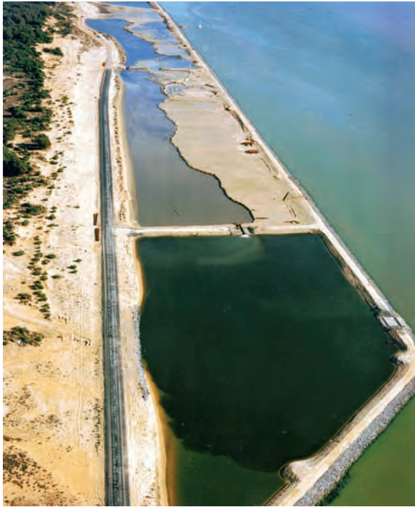
Figura 6.2.3.a Relleno con material contaminado
