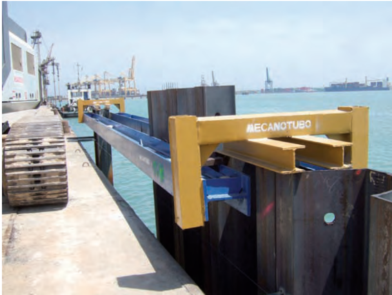
Figura 8.3.3.f Guía de tablestacas
