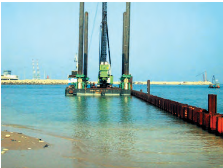
Figura 8.3.4. A Hinca de tablestacas con medios marítimos
