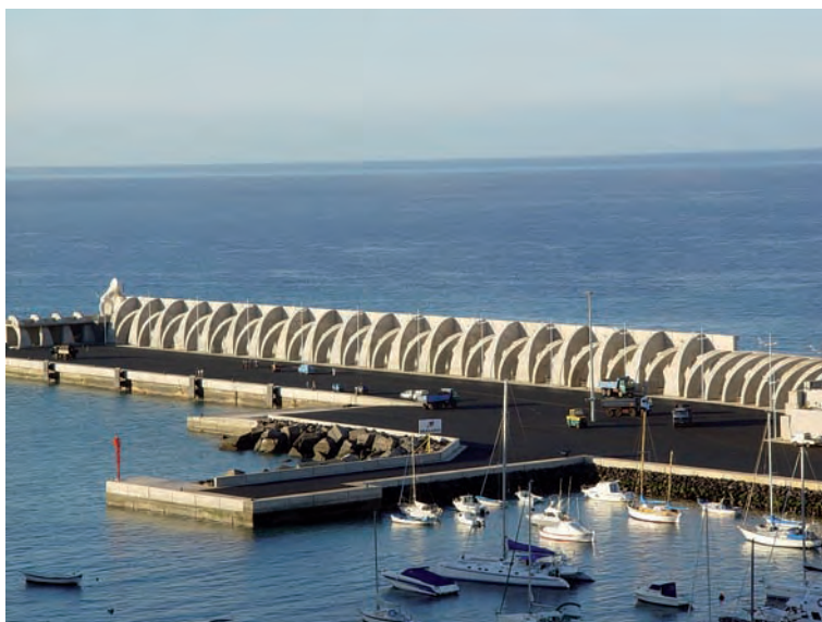
Figura 9.3.1 Espaldón de dique vertical
