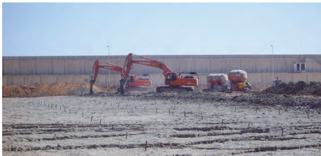
Figura 6.3.8 C Replanteo de celdas de tratamiento
