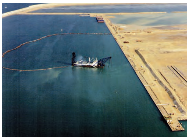
Figura 6.2.2.a Relleno procedente de dragado
