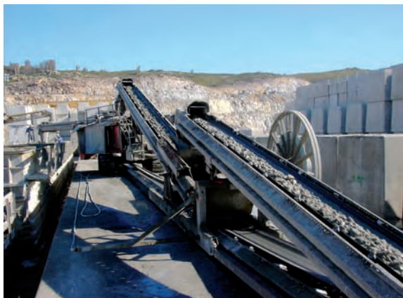
Figura 6.11.2 A Hormigonado con cinta
