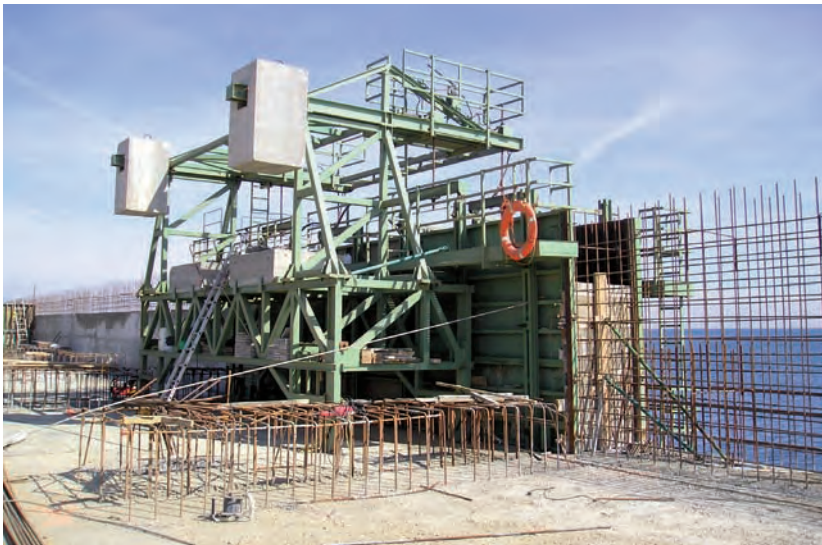
Figura 9.4.3 A Encofrado viga cantil
