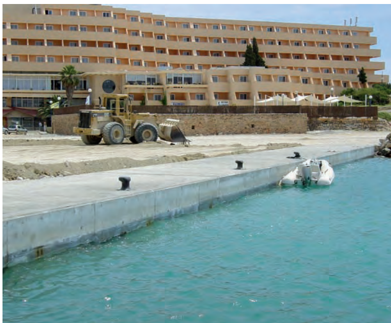
Figura 10.2 D Muelle auxiliar
