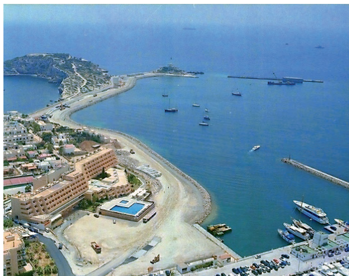
Figura 10.1 A Dique en construcción
