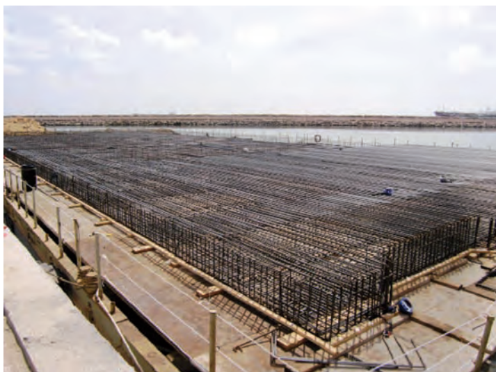
Figura 6.12.5 Armadura solera
