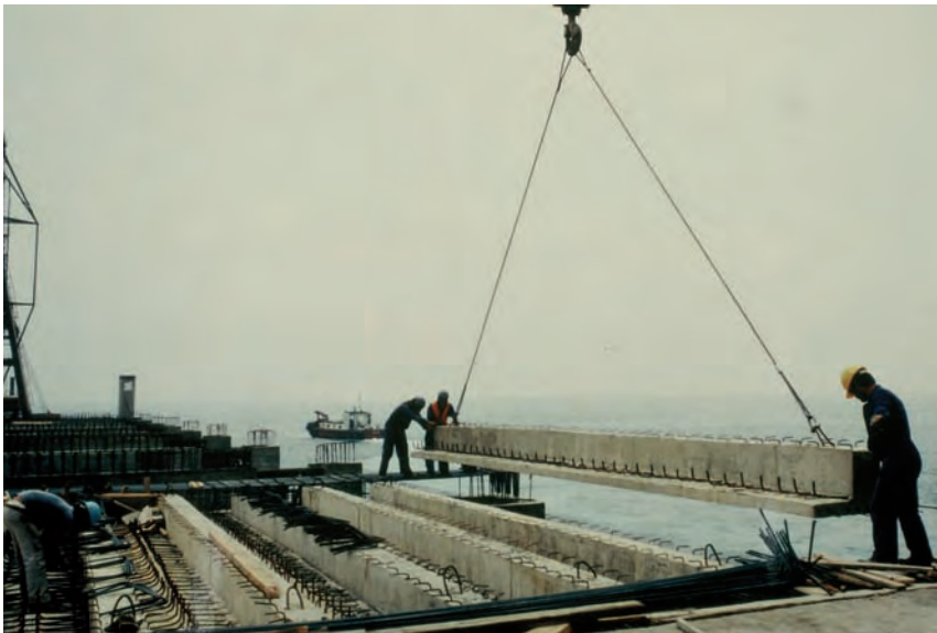
Figura 9.6.2 B Montaje de prefabricados
