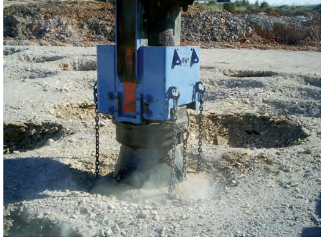
Figura 6.3.5 C Compactación dinámica rápida
