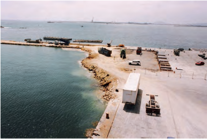
Figura 6.2.1.b A Colocación de relleno
