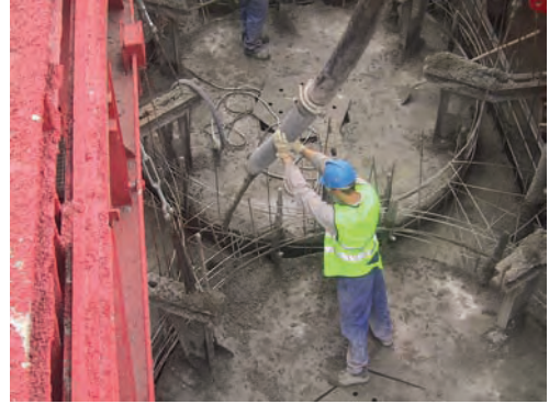
Figura 6.12.6 B Hormigón del fuste
