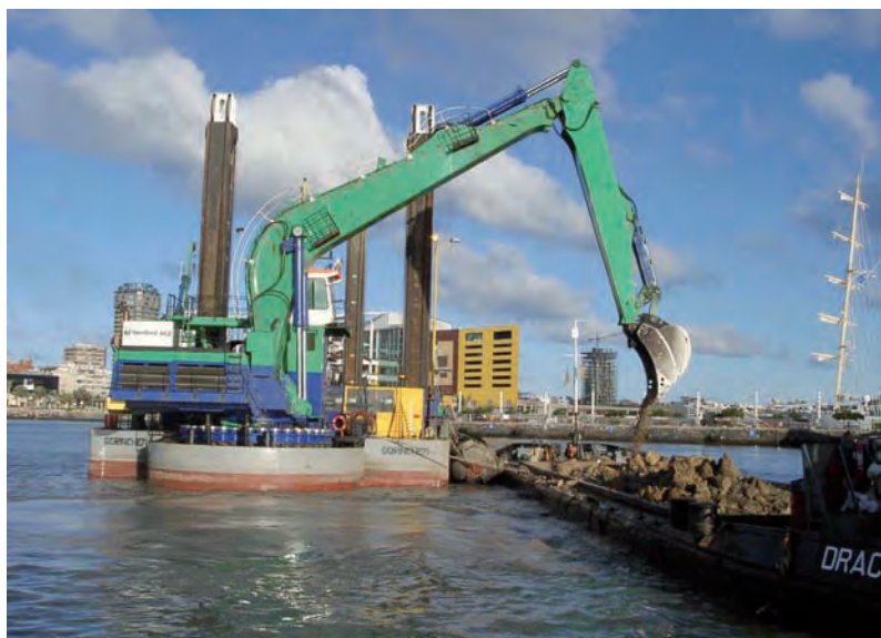
Figura 6.1.3 G Dragadora retroexcavadora
