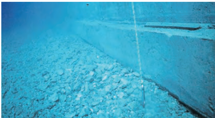
Figura 6.8.4 Comprobación del enrase tras fondear el cajón
