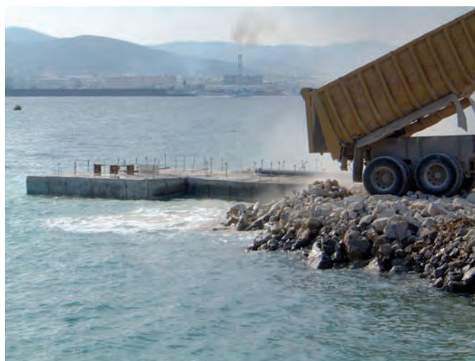
Figura 6.4.1 Relleno de trasdós
