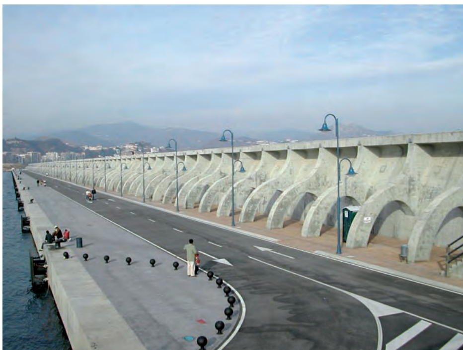
Figura 7.2.1 B Dique-muelle de Málaga
