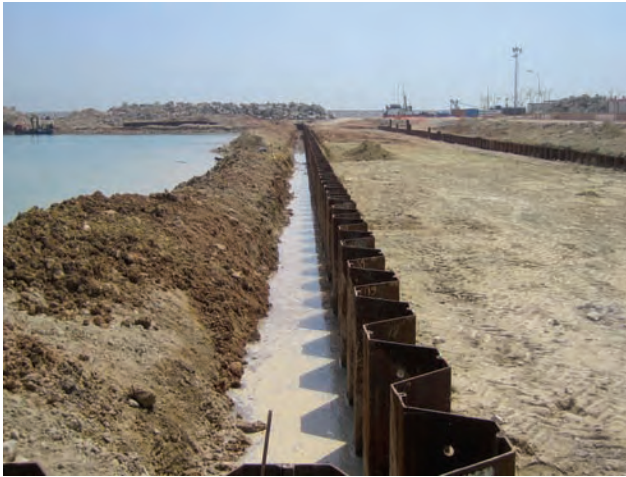
Figura 8.3.3.g A Pantalla de tablestacas
