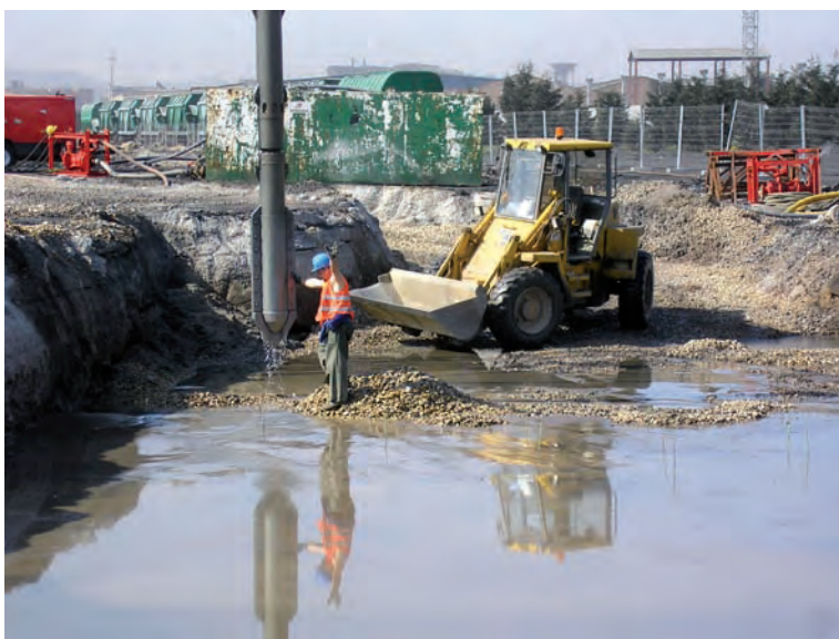
Figura 6.3.4 Vibrosustitución
