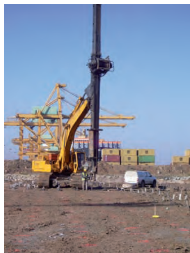
Figura 6.3.6 C Colocación mechas
