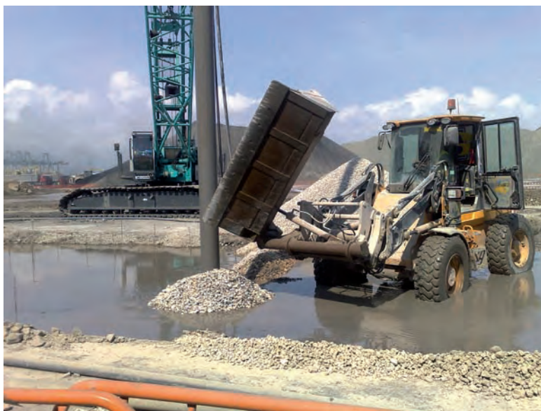
Figura 6.3.7 B Ejecución Columnas de grava en tierra
