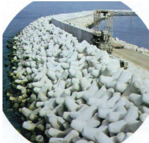
Figura 6.11.1 D Manto de Tetrápodos
