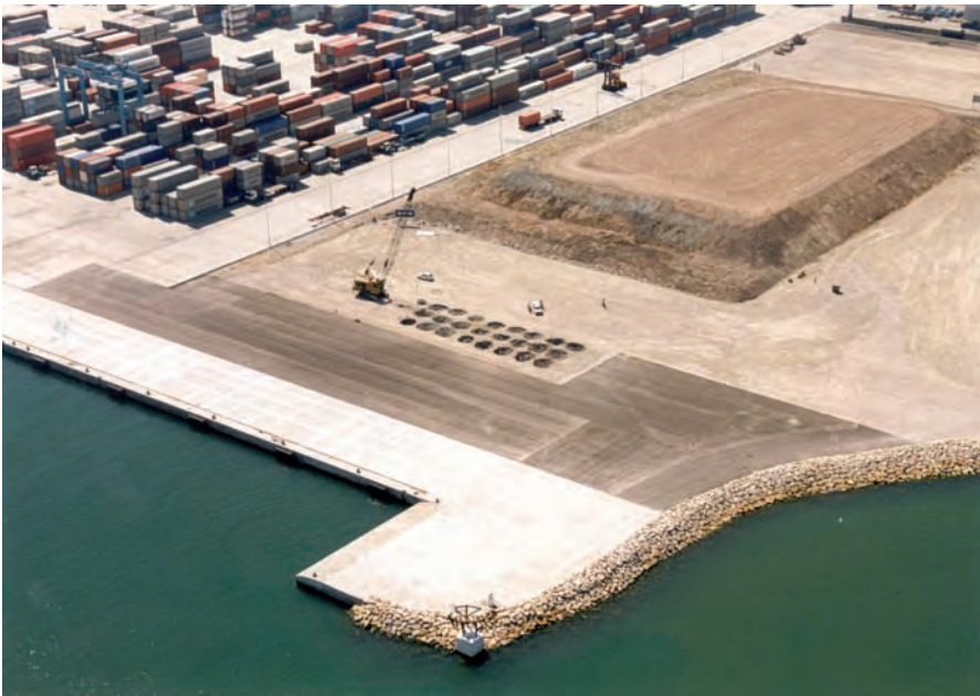
Figura 6.3.5 A Compactación dinámica y precarga
