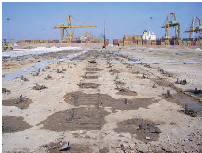
Figura 6.3.6 B Mechas de geotextil
