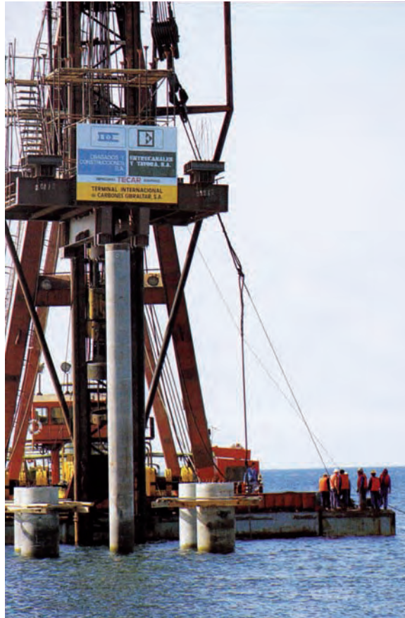
Figura 8.2.5.f Prueba de carga
