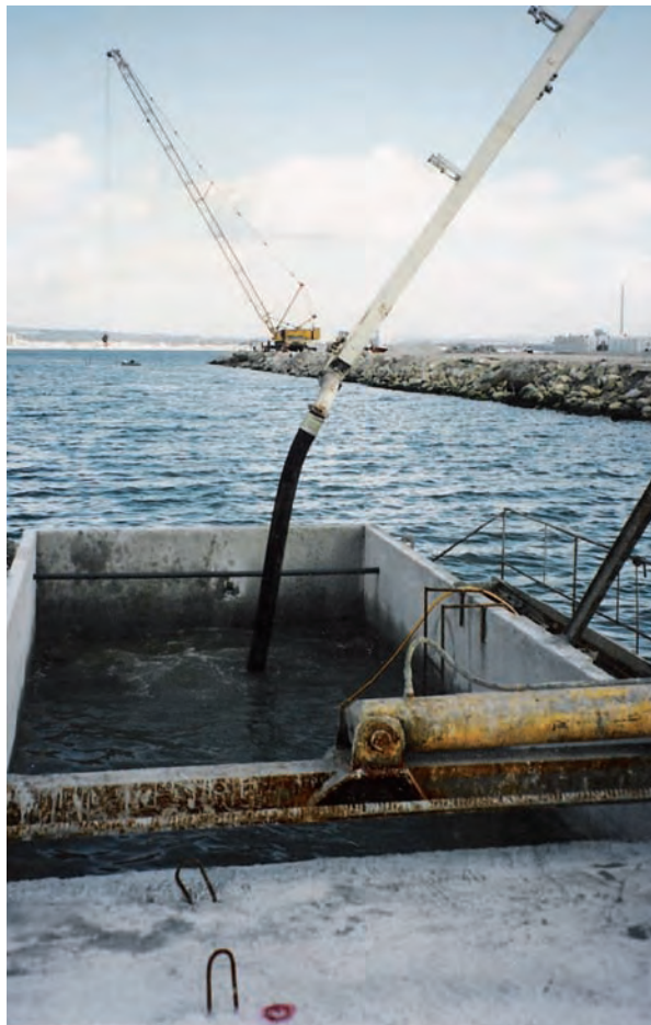
Figura 8.1.3.e Hormigonado con bomba
