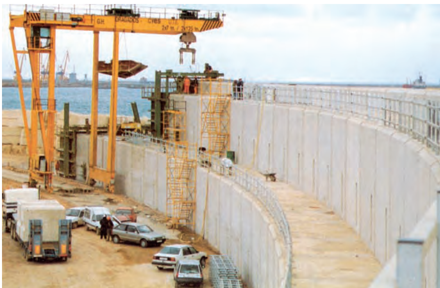
Figura 9.2.2 B Construcción espaldón
