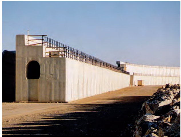
Figura 9.2.1 B Espaldón con galería
