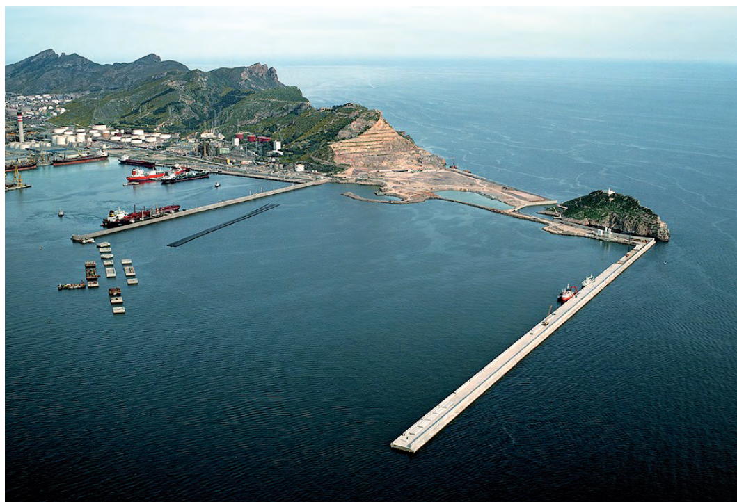
Figura 6.9.1 B Desmante de la propia obra
