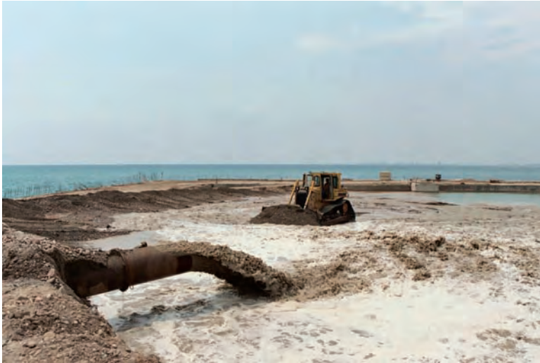
Figura 6.2.2.b A Relleno con tubería
