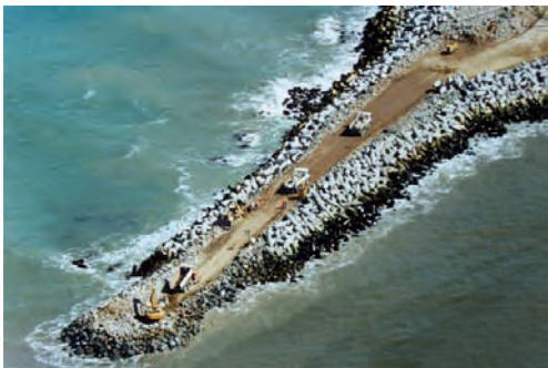
Figura 7.1.3 A Avance de un dique en construcción
