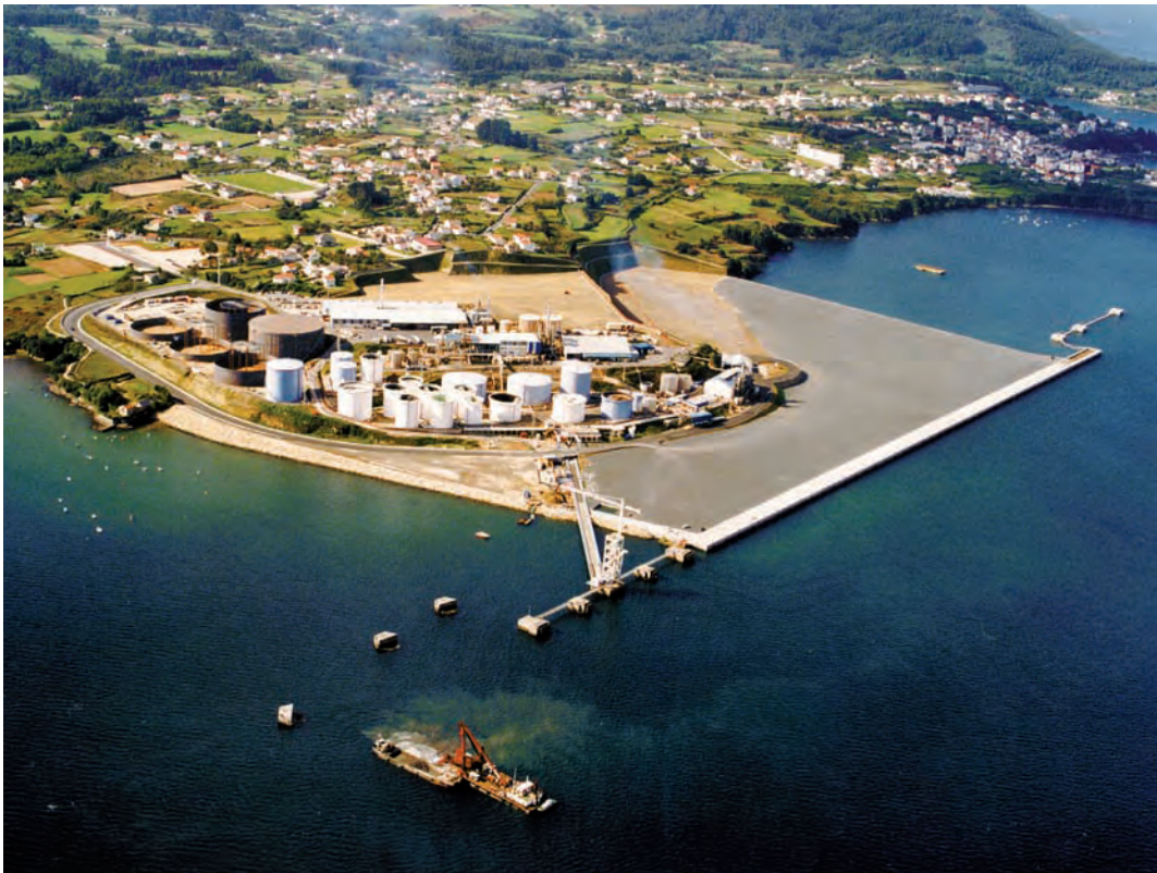
Figura 8.1.1.a A Muelle de cajones
