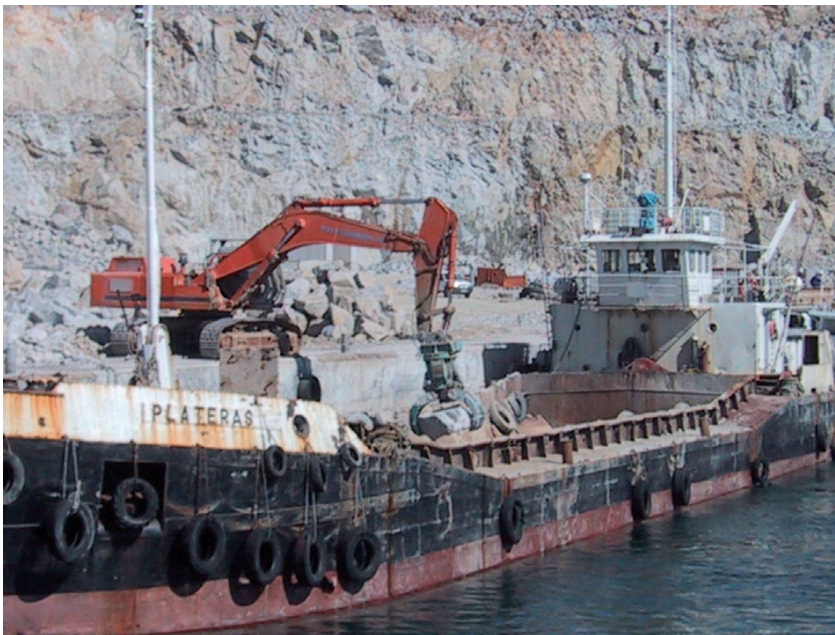
Figura 8.4.5 C Descarga en gánguil con retroexcavadora.
