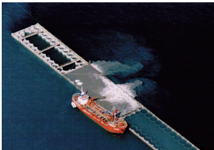
Figura 6.5.2 B Relleno procedente de dragado
