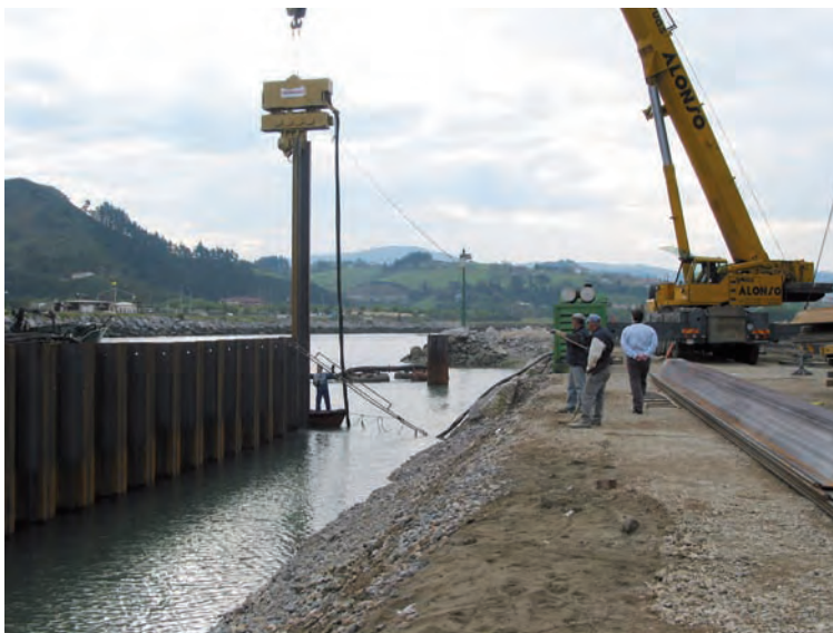
Figura 8.3.2 Hinca de tablestacas desde plataforma terrestre
