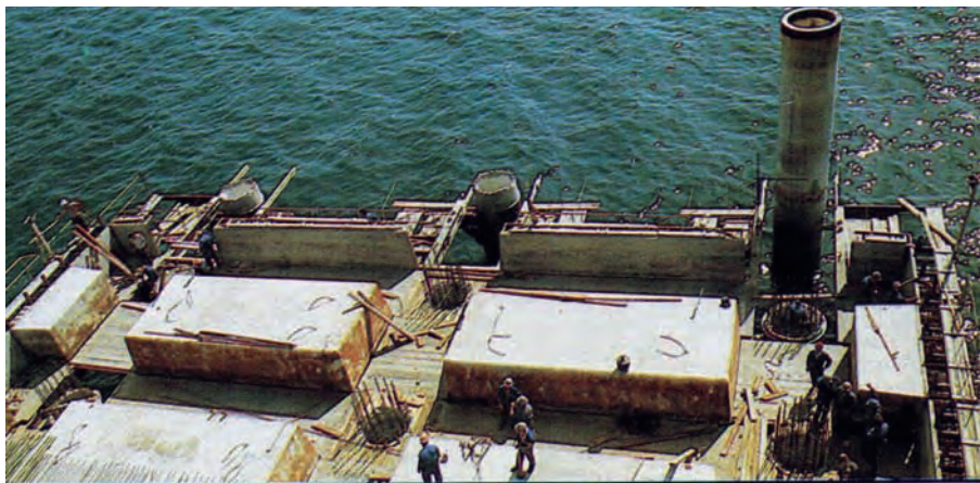
Figura 9.6.2 C Superestructura hormigonada “ in situ ”
