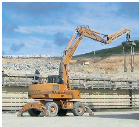
Figura 6.11.2 B Vibradores
