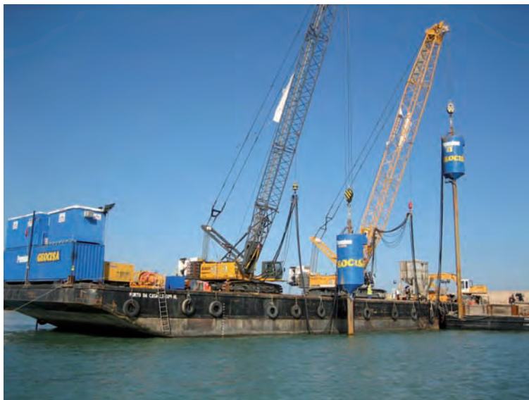
Figura 6.3.7 A Columnas de grava en fondo marino
