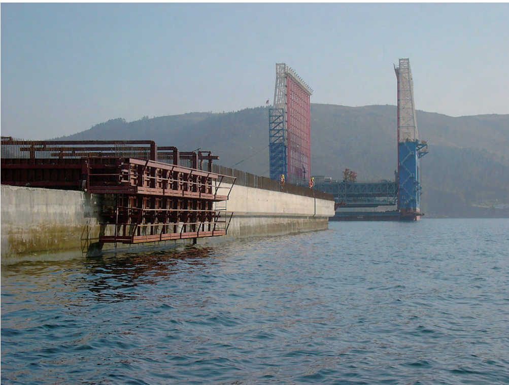
Figura 9.4.3 B Encofrado viga cantil
