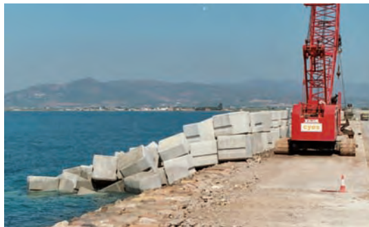
Figura 6.10.2 K Manto de escollera artificial
