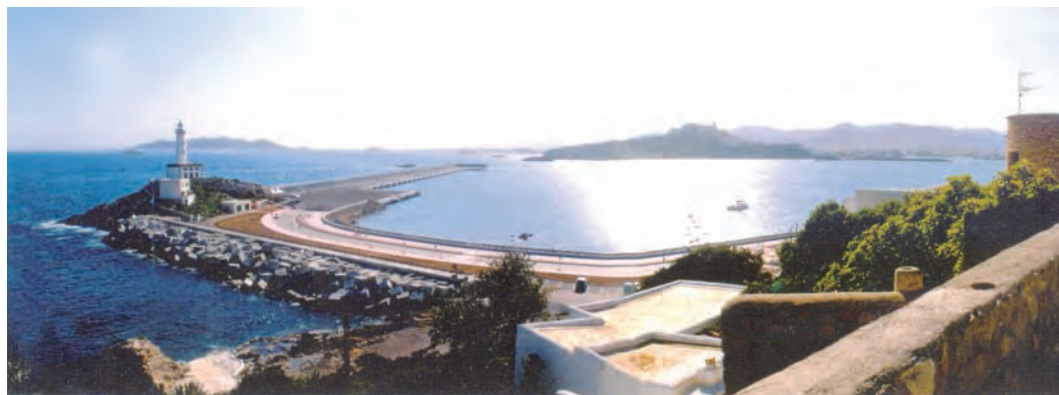
Figura 10.1 B Dique Botafoc
