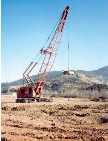
Figura 6.3.5 B Compactación dinámica clásica
