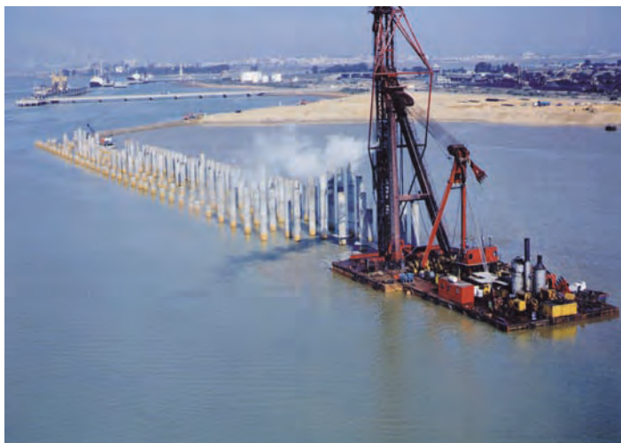
Figura 8.2.5.e A Hincas de pilotes con cabria
