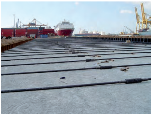
Figura 8.3.3.g B Anclajes
